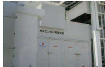
播磨事業所に、環境負荷が小さく稼働時の騒音も小さいガス発電機を導入しました。これに、近隣の住民の方への配慮として高さ10mの防音壁を設けることで、きわめて騒音防止効果の高い設備となりました。この発電機は、夏のピーク電力を抑えるため緊急電力の供給を担うほか停電時の補助に用いられ、計画停電時でも容易に止められない設備が稼働できます。
