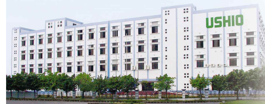
番禺工場 <広州市番禺旧水坑牛尾電機廠>
