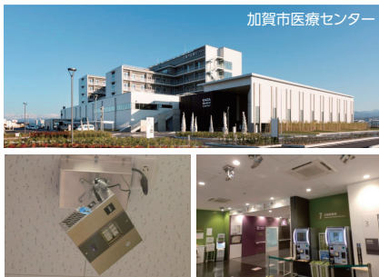
天井に設置されたCare222®U3ユニット
