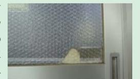
ウシオ香港では空調電力の削減の目的でメイン玄関の太陽光遮断フィルムの貼り付けを行いました。クリスティ・デジタル・システムズカナダでは、老朽化した屋根の吹き替えに際し、断熱加工を施した上、高反射率の屋根ふき材を採用、南向きの窓にウインドウフィルムを貼るなどの断熱対策を実施しています。
