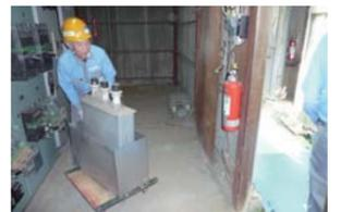
高濃度 PCB コンデンサー運搬
