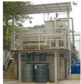
凝集沈殿装置
