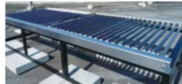
(上) 円筒型太陽電池の実装例
