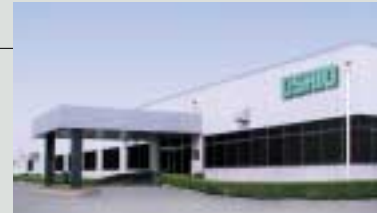
蘇州工場 <牛尾電機(蘇州)有限公司>
